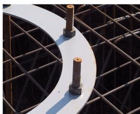
Gli inseguitori di tipo Pillar richiedono la realizzazione di opere di fondazione per l'ancoraggio in sicurezza del pilastro. Questo viene fissato alle fondazioni per mezzo di tirafondi. E'
